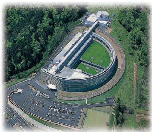
若狭湾エネルギー研究センター
