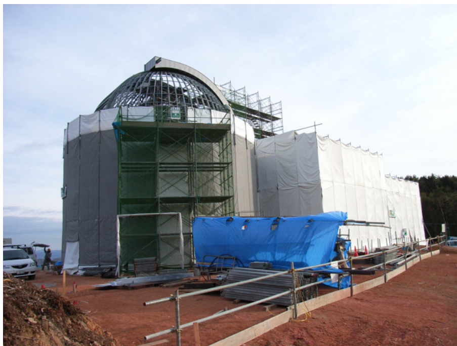
図 3.5: 広島大学天文台建設地
